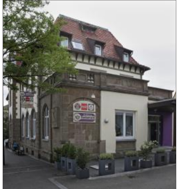
Imposant: Das historische Gebäude in der Bahnhofstraße 19.
